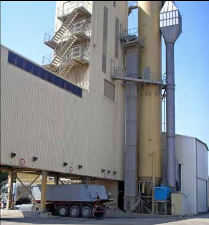
Absaugen von Steinstaub in Mischbetrieben bei der Produktion von Zuschlagstoffen (wie „Füller“) für die Asphaltindustrie.
