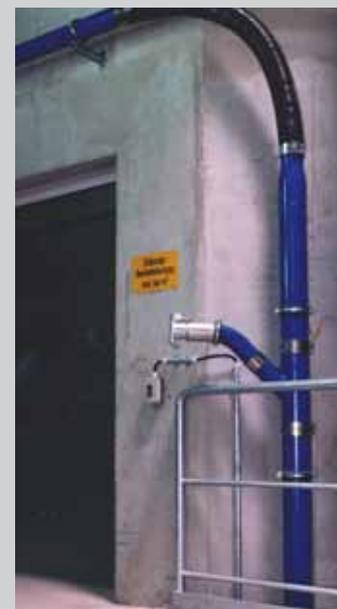
Rohrleitung mit Sauganschluss DN 50 für Anlagen- und Bodenreinigung in den einzelnen Ebenen
